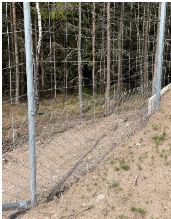
Förslag på montage av nät vid viltuthopp
