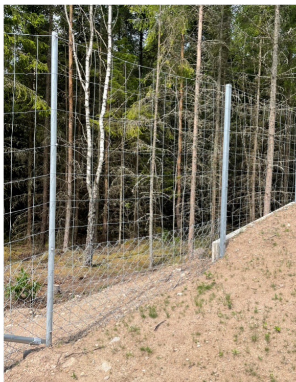
Montage av nät vid viltuthopp, se till att höjden mot marken på viltsidan behålls
