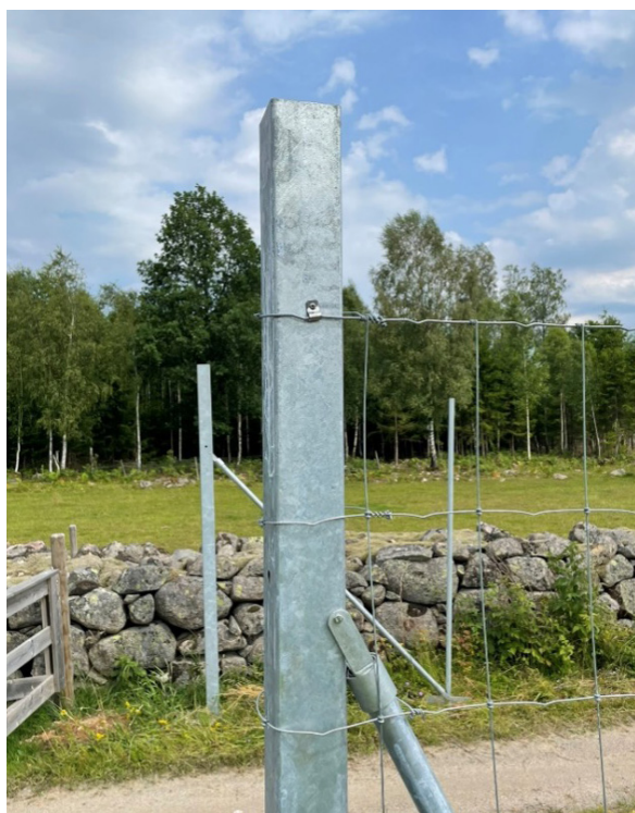
Infästning av nät vid grindstolpe eller avslut, dra tråd rund stolpe och använd bläck Stag för att motverka dragkraften från nätet
