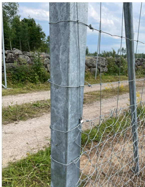
Infästning av nät runt ändstolpe / Grindstolpe Tråd virad runt stolpe och monterad med klammer
