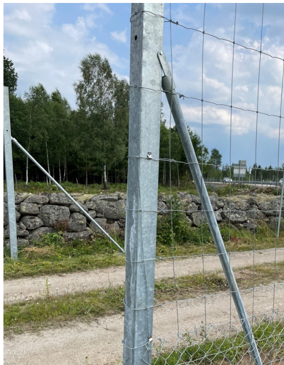
Montage av ändstolpe, med stag
