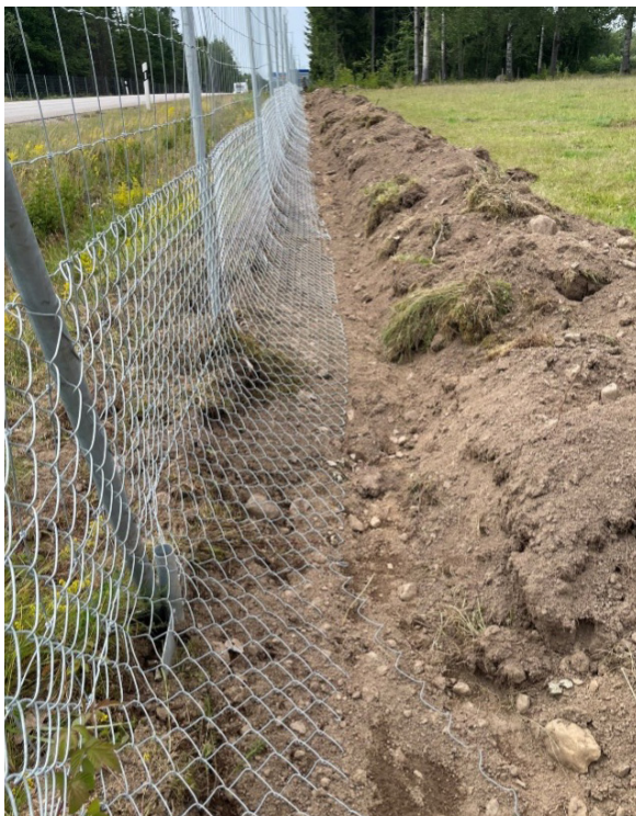
Grävning för faunanät, ca 10 djupt eller enligt teknisk beskrivning
