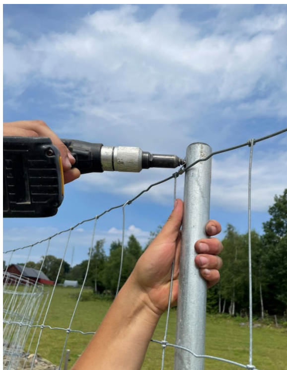
Montage av nät på stolpe med pop och bläck, i förborrade hål, höjd 220 cm över mark, +/- 10 cm beroende på terräng
