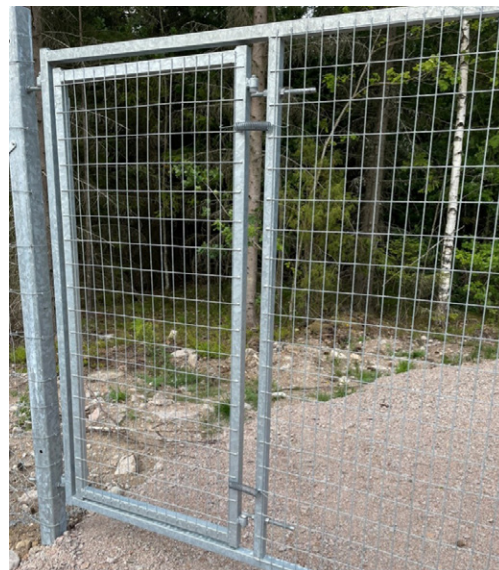
Montage av gånggrind i fordonsgrind
