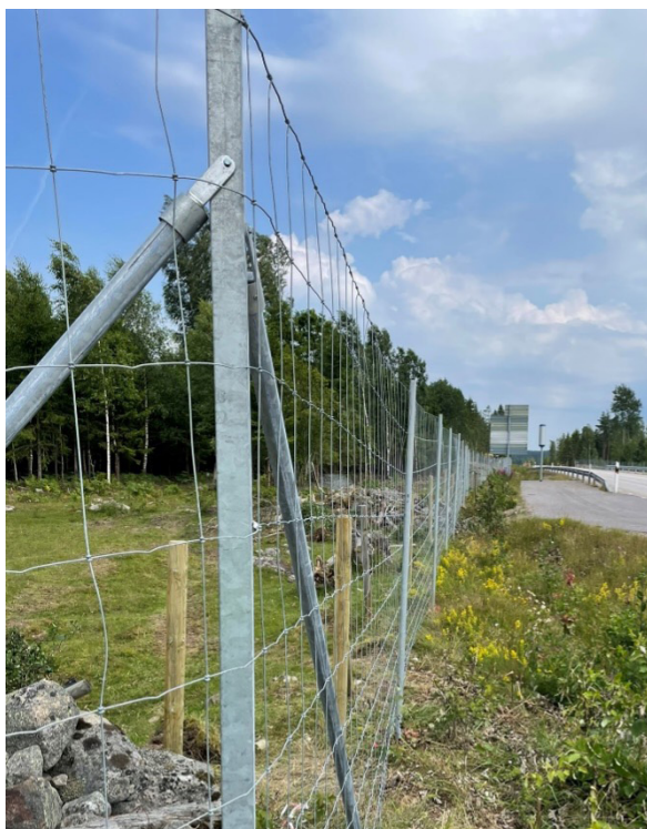
Montage av hörnstolpe med stag, nät på utsidan av stolpe
