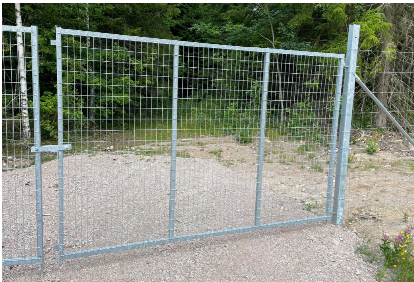
Montage av fordonsgrind, gjutna stolpar och infästning
