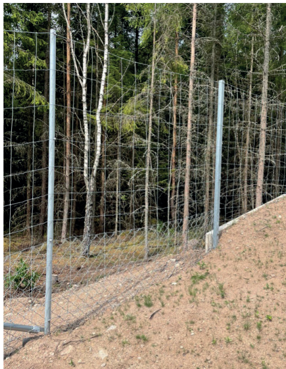
Montage av nät vid viltuthopp, se till att höjden mot marken på viltsidan behålls
