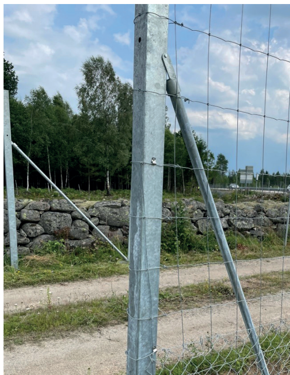
Montage av ändstolpe, med stag
