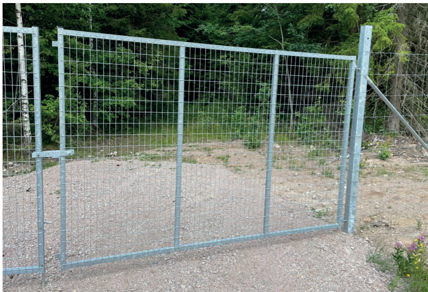
Montage av fordonsgrind, gjutna stolpar och infästning
