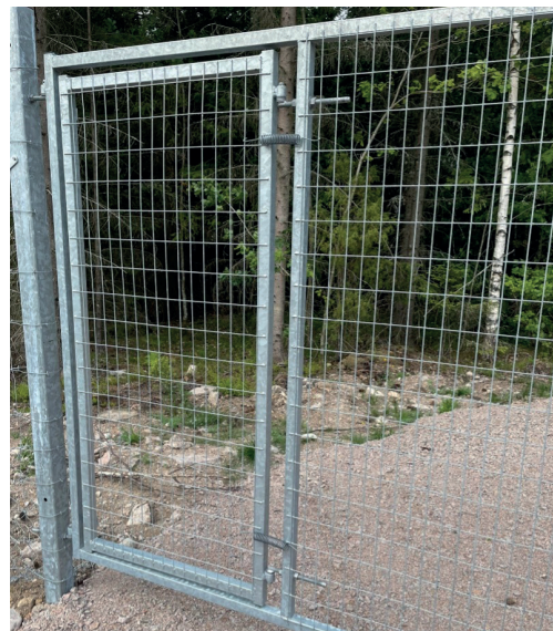
Montage av gånggrind i fordonsgrind
