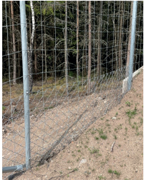
Montage av nät vid viltuthopp
